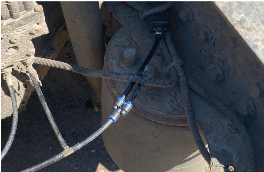
рис. 0.4. Подключение пневмомагистралей завершено
