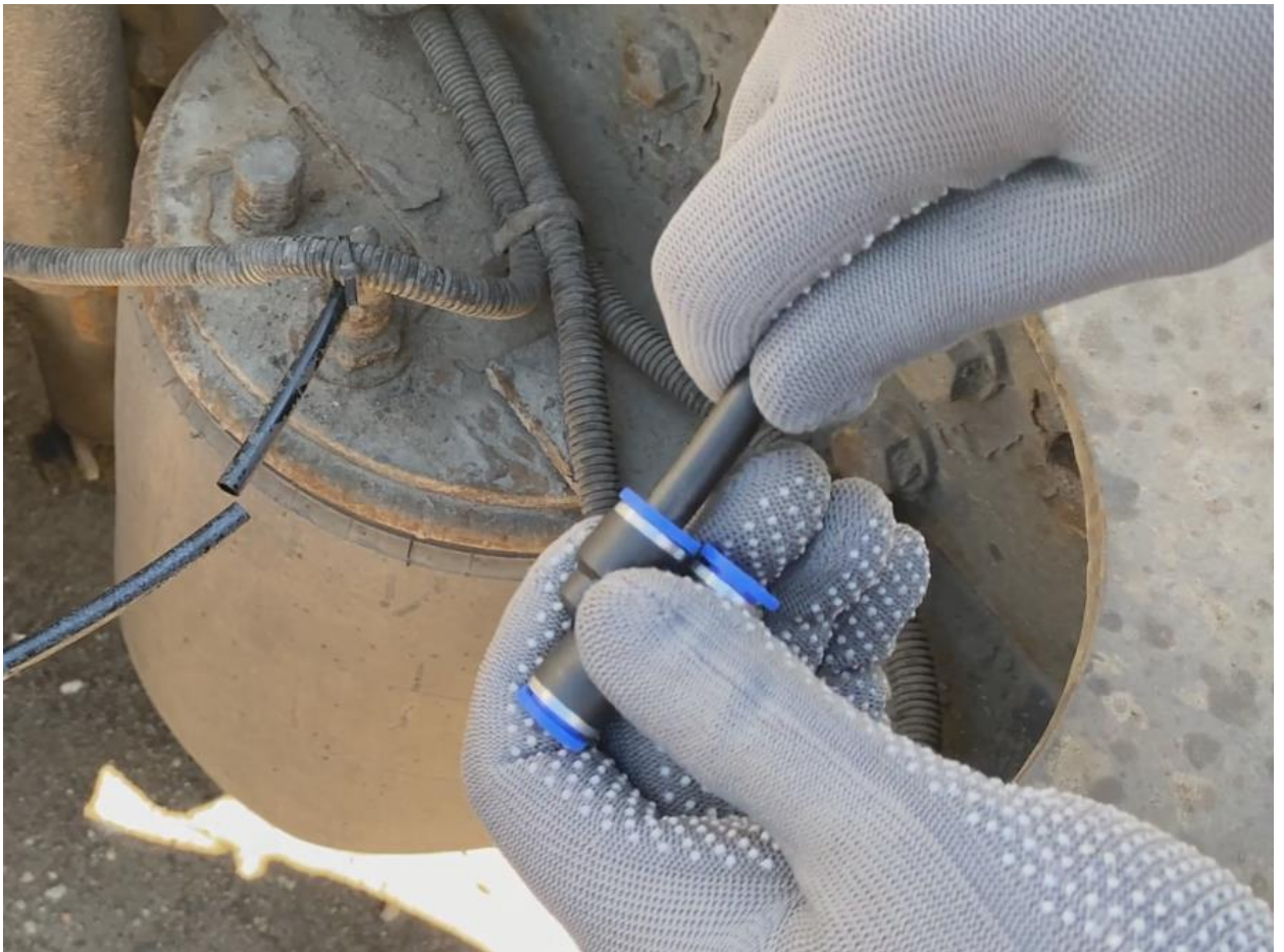
рис. 0.3. Установка пневмотрубки датчика в фитинг-тройник
